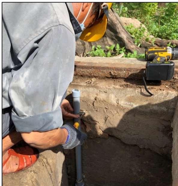
Hình 3.5 Minh họa quá trình lắp đặt sensor ghi mực nước
