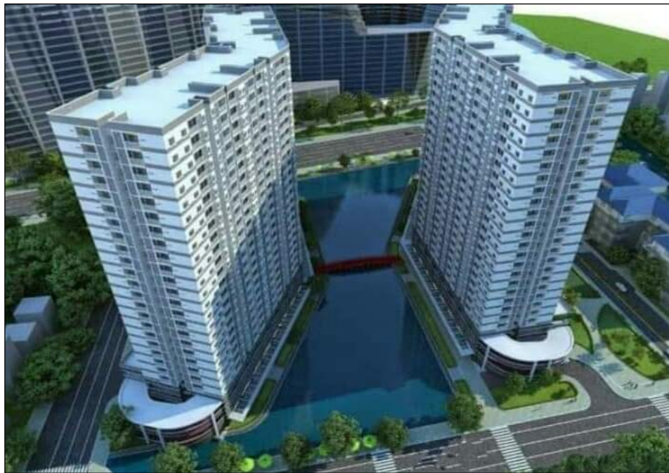
Hình 4.16 Mô hình trữ nước mưa và điều tiết dòng chảy tràn tại khu vực Jamonacity, Đào Trí, Quận 7
