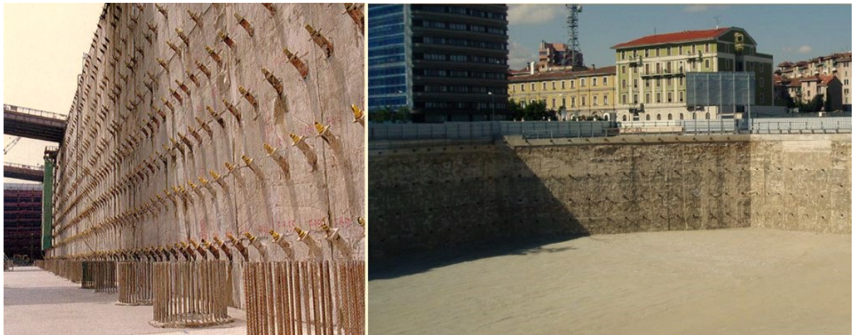
Hình 2.19 Minh họa tường vây khi thiết kế hồ ngầm
