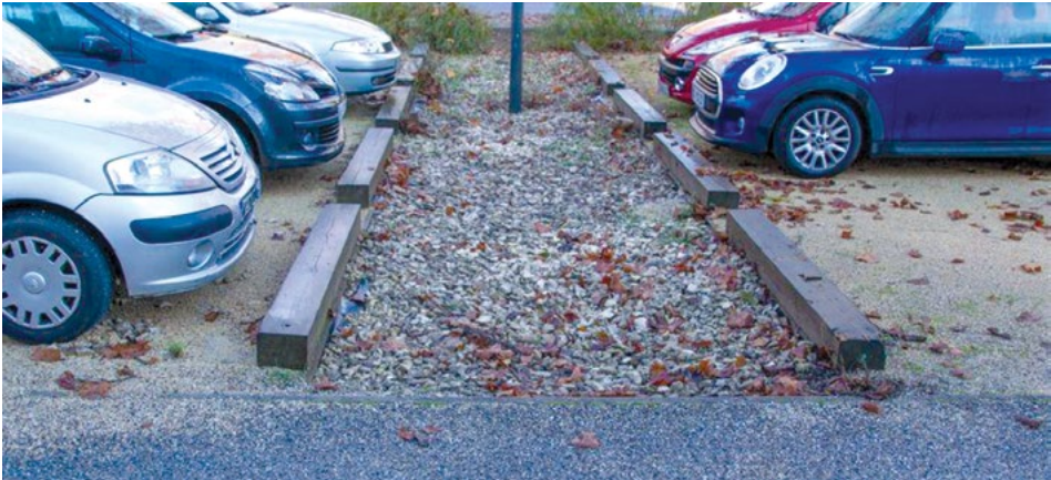
Hình 4.1 Rãnh thấm được xây dựng trong khu đậu xe
