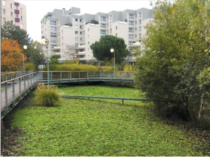
Hình 4.12 Hồ trữ nước mưa và thấm
