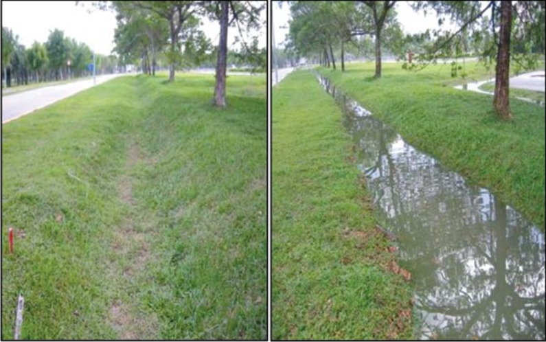
Hình 2.13 Rãnh thấm khô và ướt tại khuôn viên Đại học Sains, Malaysia
