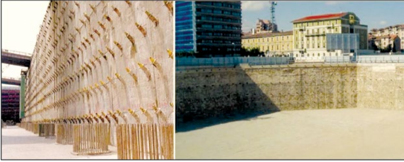
Hình 2.6 Minh họa tường vây hồ ngầm
