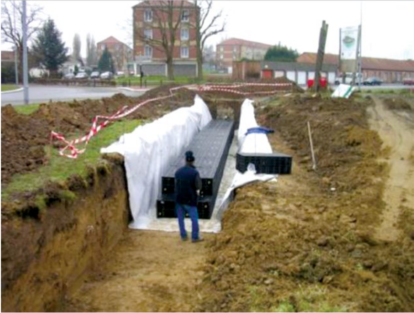
Hình 4.8 Hồ ngầm bằng mô-đun lắp ghép
